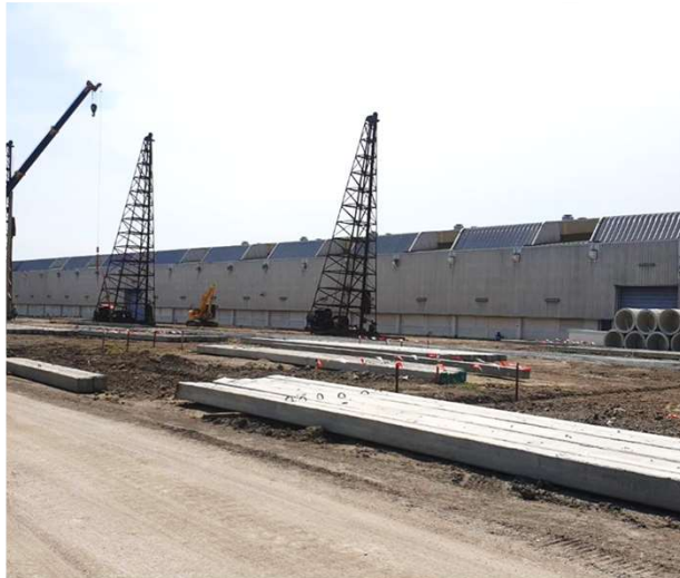
BTMT PHASE 5 Location นิคม อุตสาหกรรมอมตะ ชลบุรี
