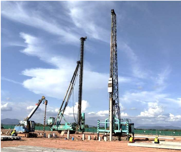
Mango BKK-062 Early work Project นิคมอุตสาหกรรม WHA 4
