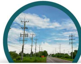
งานเสาไฟฟ้า
