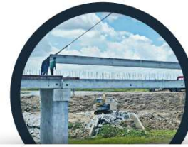
งานสะพาน
