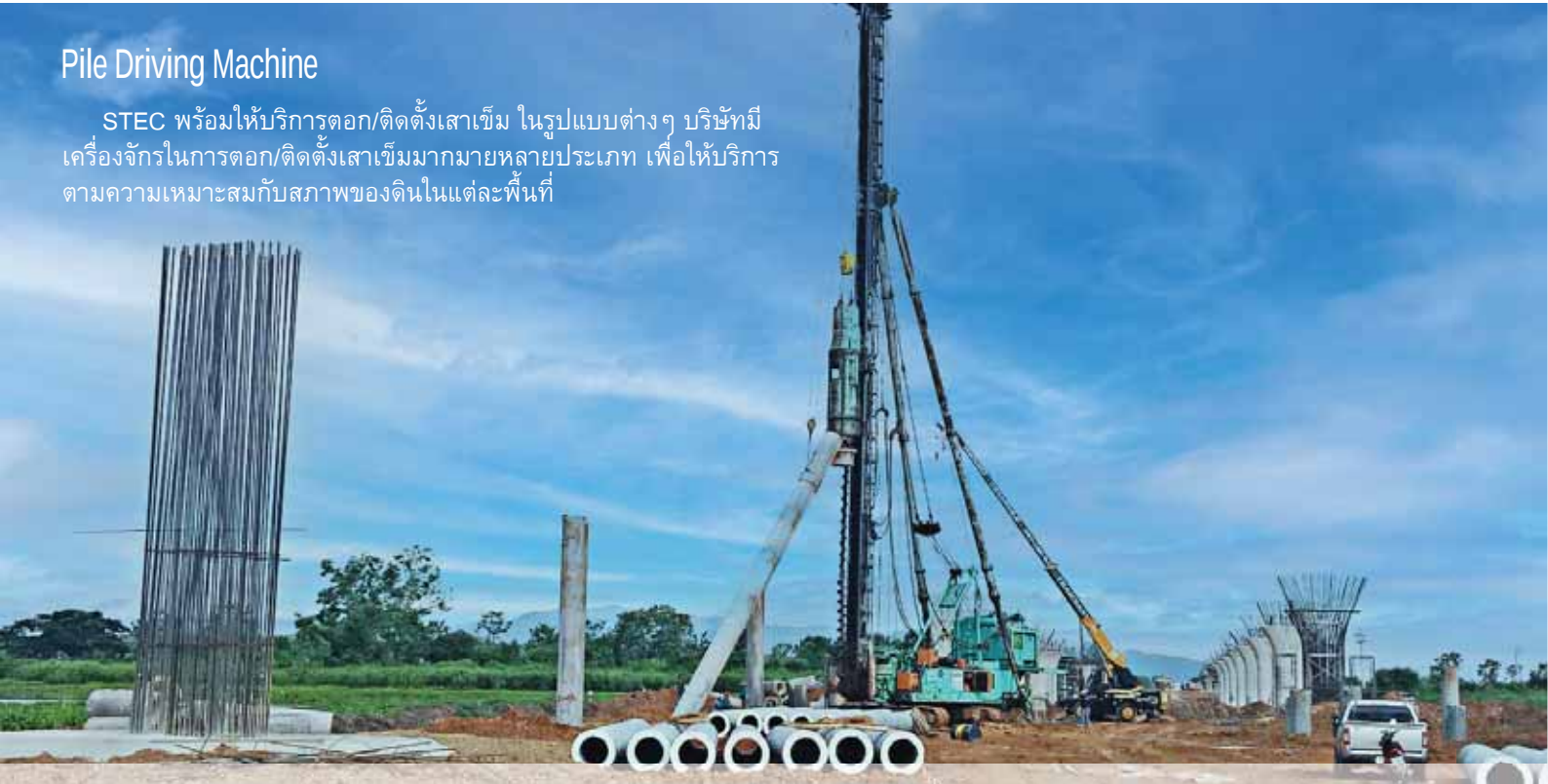
01 เครื่องกดเสาเข็ม ( Jack in Pile )
